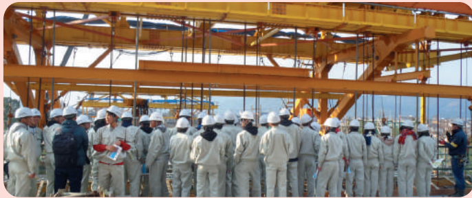
しらさぎ橋の現場にて
